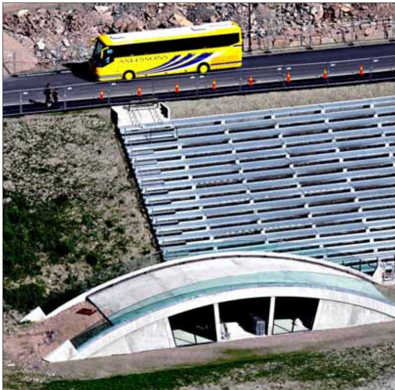
KLES MED SNØ: Mye betong har gått med til det nye Holmenkollenanlegget. Her fra skiskytterstadion. (Foto: Tom A. Kolstad)
