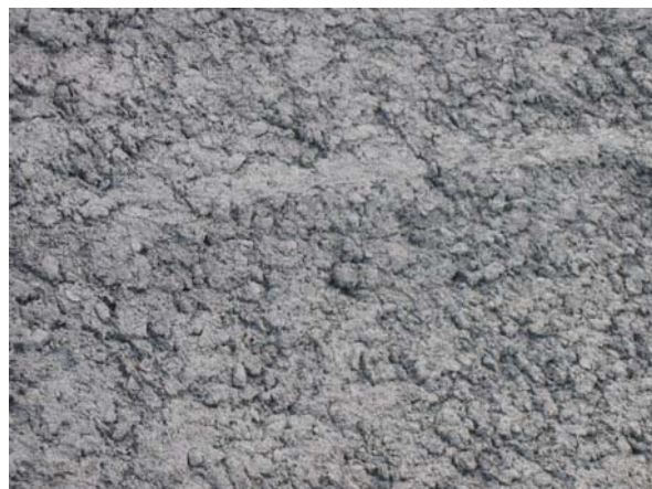
Figur 17 Overflate etter avretting
