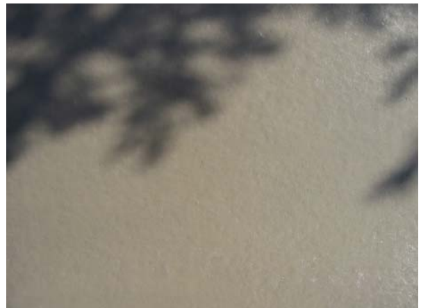
Figur 21 Overflate etter avretting med stålsverd
