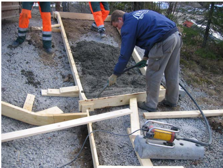
Figur 15 Utlegging og vibrering av betongen
