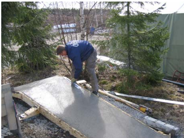
Figur 20 Finglatting med stålsverd
