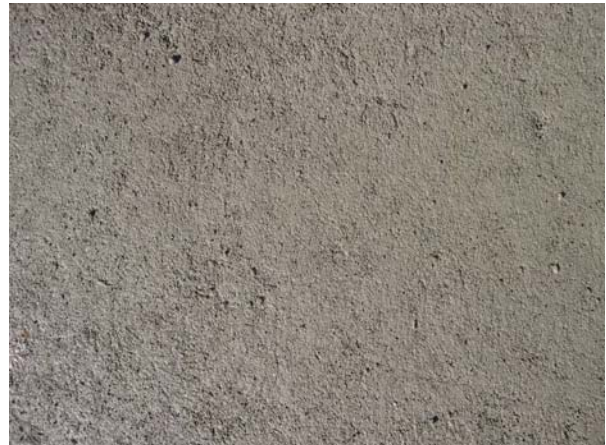
Figur 19 Overflate etter avretting med rettebrett
